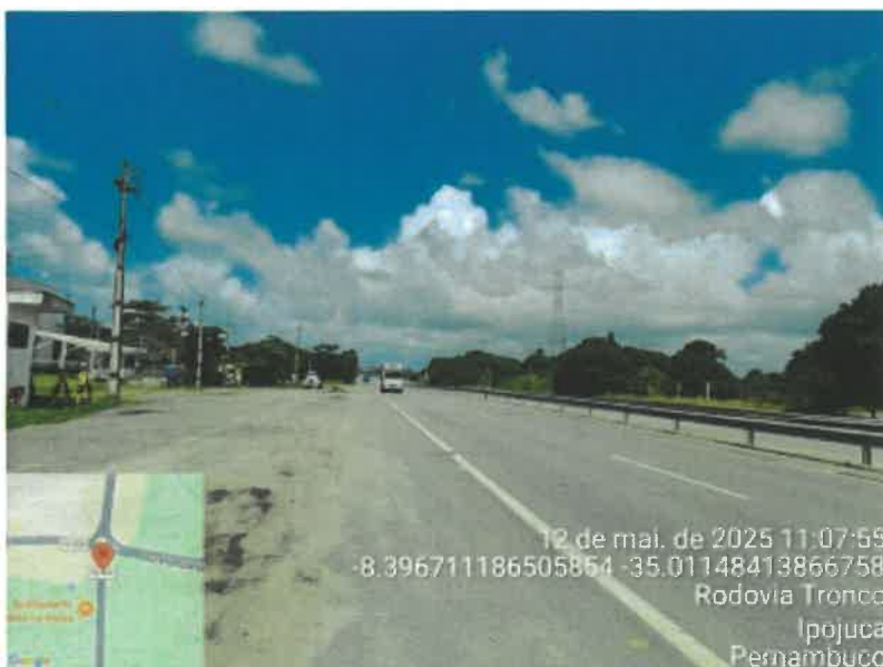
Imagem Rodovia PE-009 - local de instalação do equipamento
