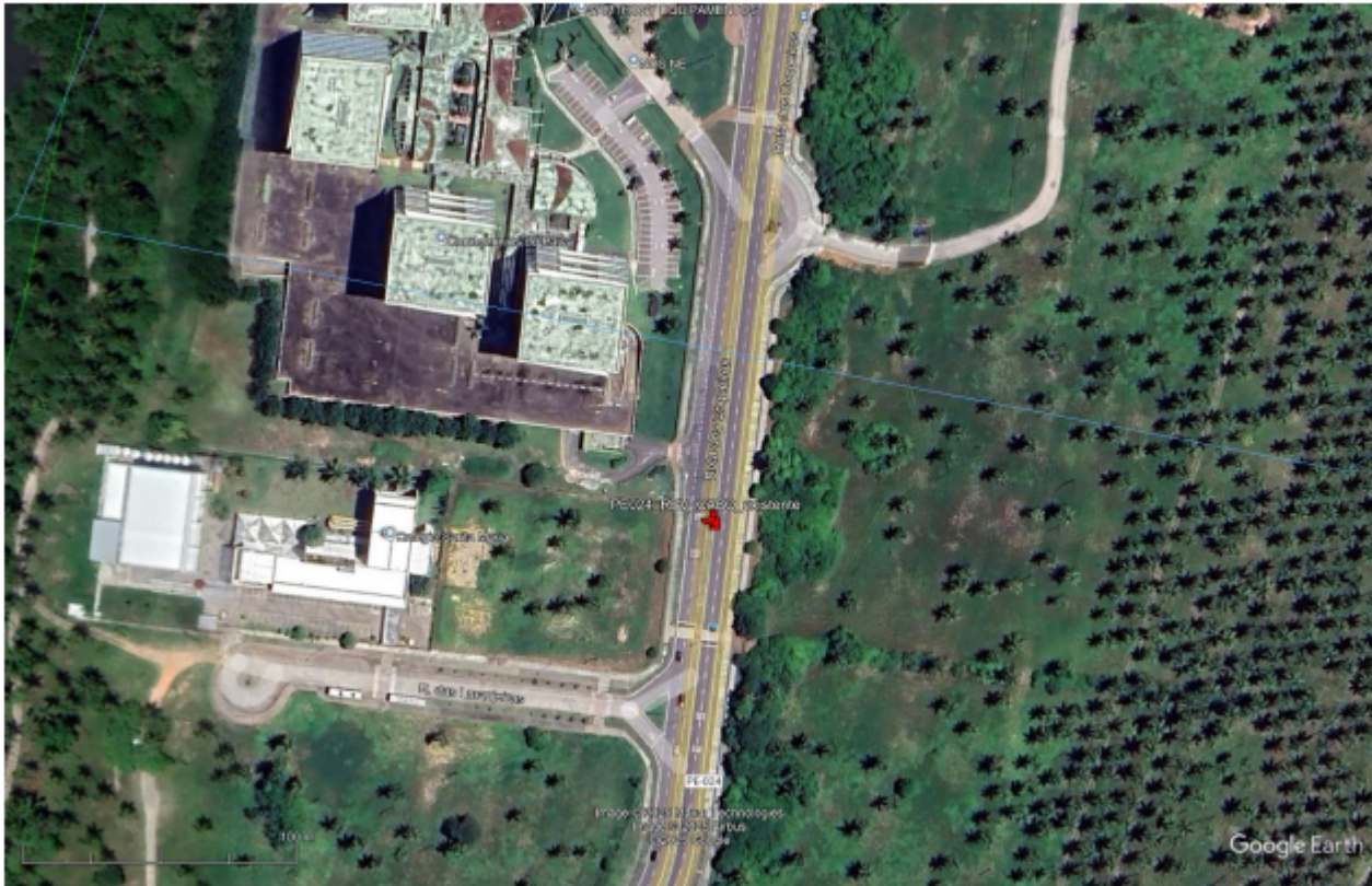
Imagem Vista Superior da Rodovia PE-024 - local de instalação do equipamento - Fonte: Google Earth
