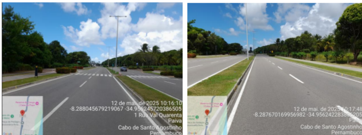
Imagem Rodovia PE-024 – local de instalação do antigo equipamento e dos novos equipamentos
