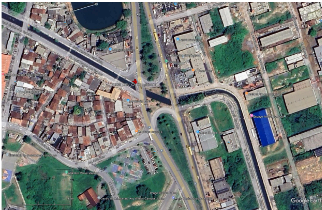
Imagem Vista Superior da Rodovia PE-060 - local de instalação do equipamento - Fonte: Google Earth
