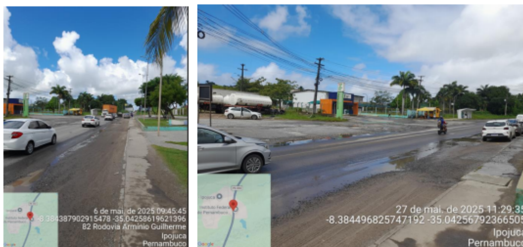
Imagem Rodovia PE-060 - local de instalação do equipamento antigo e do novo equipamento
